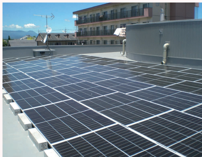
沖縄支店屋上 太陽光発電設置
